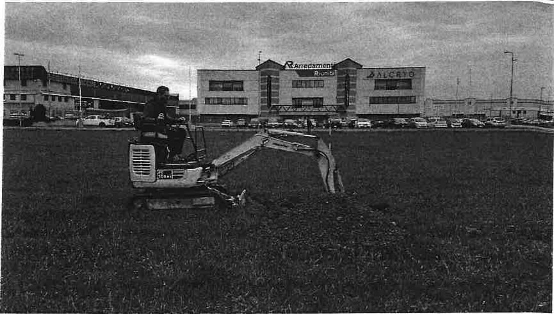
Immagine n. 11: realizzazione dello scavo geognostico A2 (sullo sfondo via Pietro Nenni)
