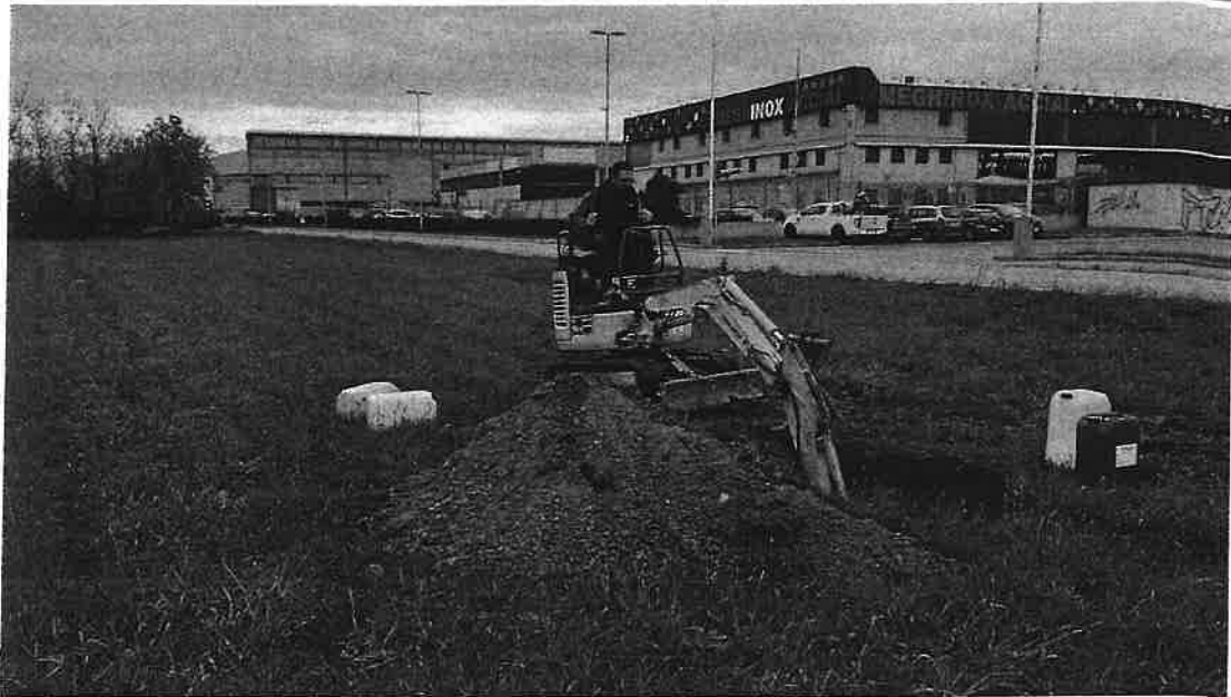
Immagine n. 8: realizzazione dello scavo geognostico A1
